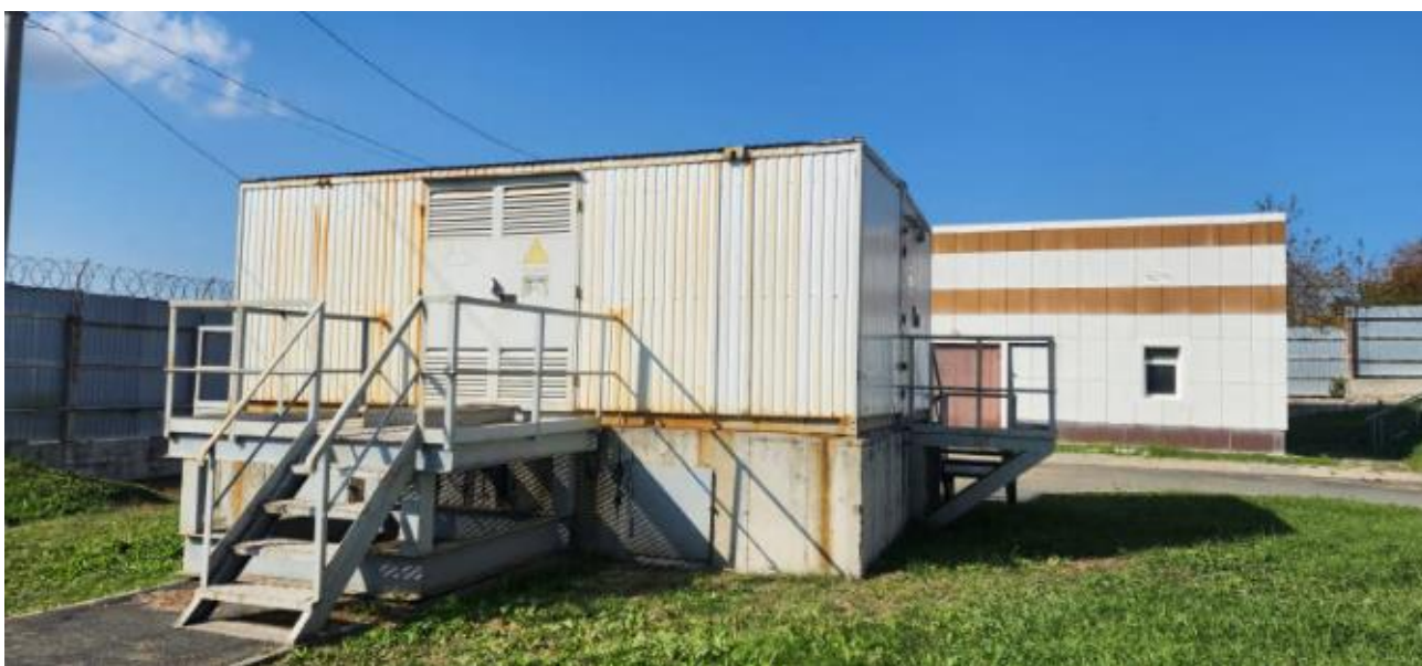
5. Комплектн. трансформаторная подстанция 2 БКТП - П - К/К-160-10/0,4 - У1
